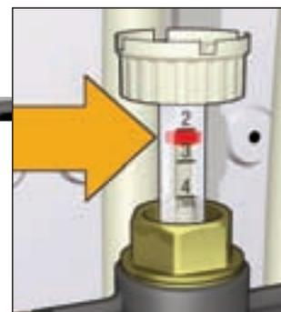
La portata va letta direttamente sulla scala graduata espressa in l/min, stampata direttamente sul flussometro.
